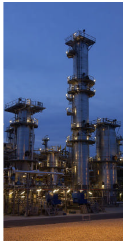
Synflex-anlægget der nu producerer svovlfri diesel.
